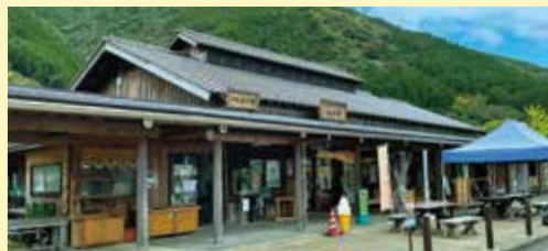
国道445号線沿いに位置し、まさに山の中のオアシス的存在の道の駅。
